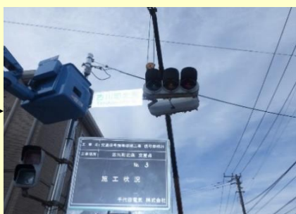
④灯器を取り付けて、配線をします。
