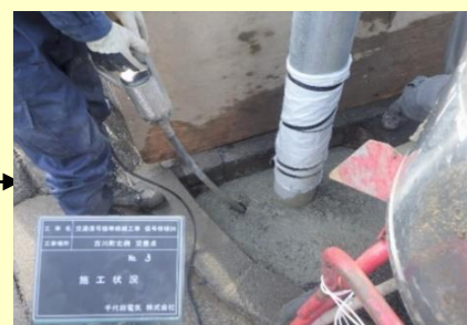
③コンクリートを流し込みます。
